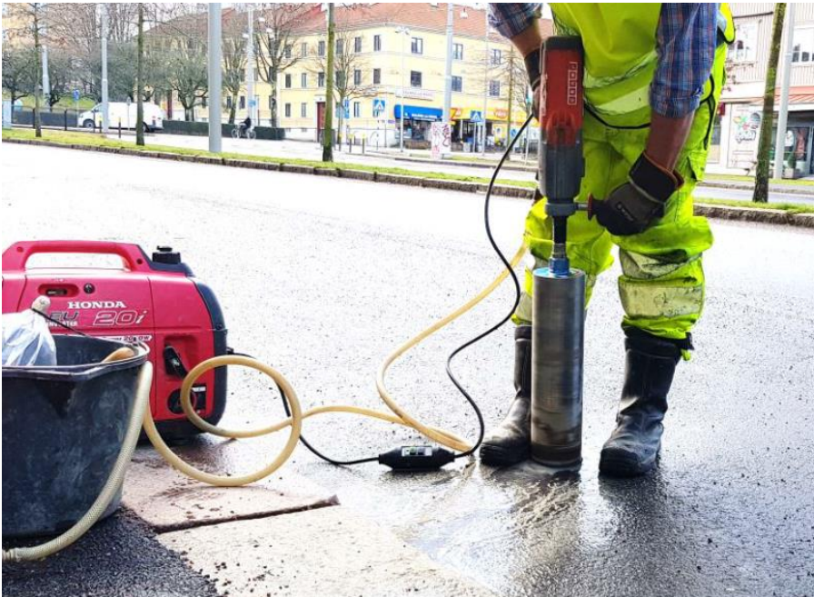
Figur 2: Asfaltsprovtagning med kärnborrhutrustning (Bildkälla: Sweco)
