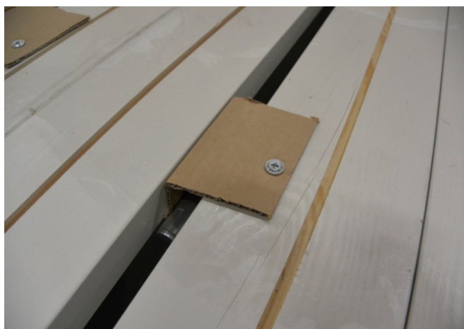
Bild 5. Wellpapp kan skydda karmar mot skavmärken från gångjärnen om inte regler eller skivmaterial används för att fixera dörrpartierna.
