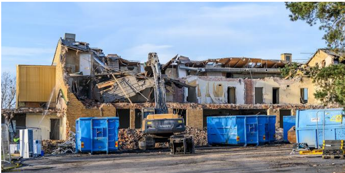
NORRBERGASKOLAN, PÅGÅENDE RIVNING FOTO: BENGT NYMAN
